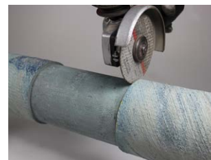
Kapa och fasa därefter röret med de verktyg och maskiner du normalt använder.
