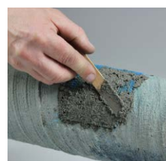
Utjämna betongskiktet och låt det torka.
