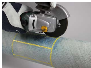
Skär med vinkelslip alternativt använd vass plattmejsel för att knacka igenom betongen runt om samt längs med röret på den yta som skall friläggas.
