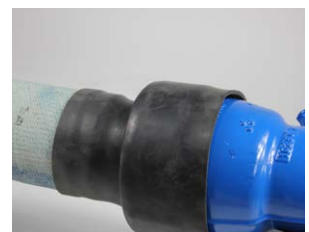
Montera på vanligt sätt och glöm ej utvändigt gummimanschett eller krympslang.
