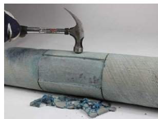
Genom att knacka med en penhammare eller motsvarande kan betongen nu avlägsnas.
